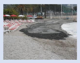
L'objectif est d'abaisser de 1,5 m la passe de l'entrée du Port. Les ports sont pollués par les hydrocarbures et les rejets des bateaux qui se déposent au fond. Les travaux de dragage et de rechargement des plages des Sablettes a été suivi par la DTM qui assure qu'il n'y a aucun problème pour faire des châteaux de sable dans ces sédiments non traités.
